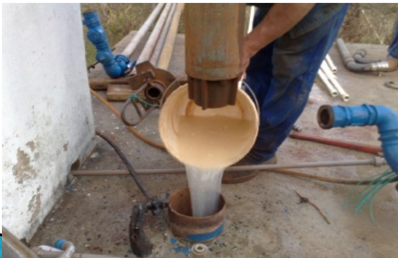
Desinfecção do poço.
