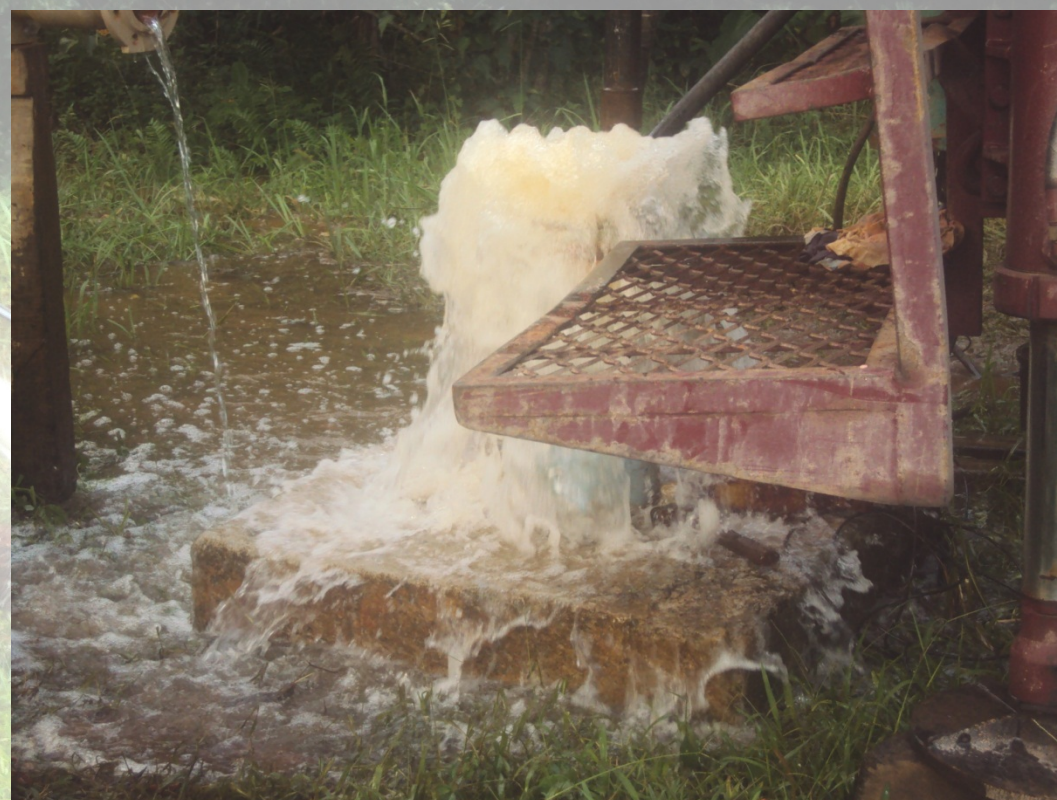
Desenvolvimento do poço
