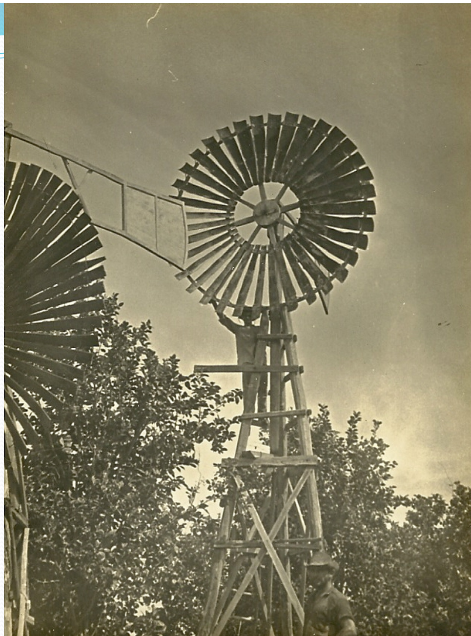
Foto 6 – Típico catavento de madeira usado em poços amazonas na planície aluvial do baixo Jaguaribe para irrigação de laranjais. Município de Russas – CE 1963.
