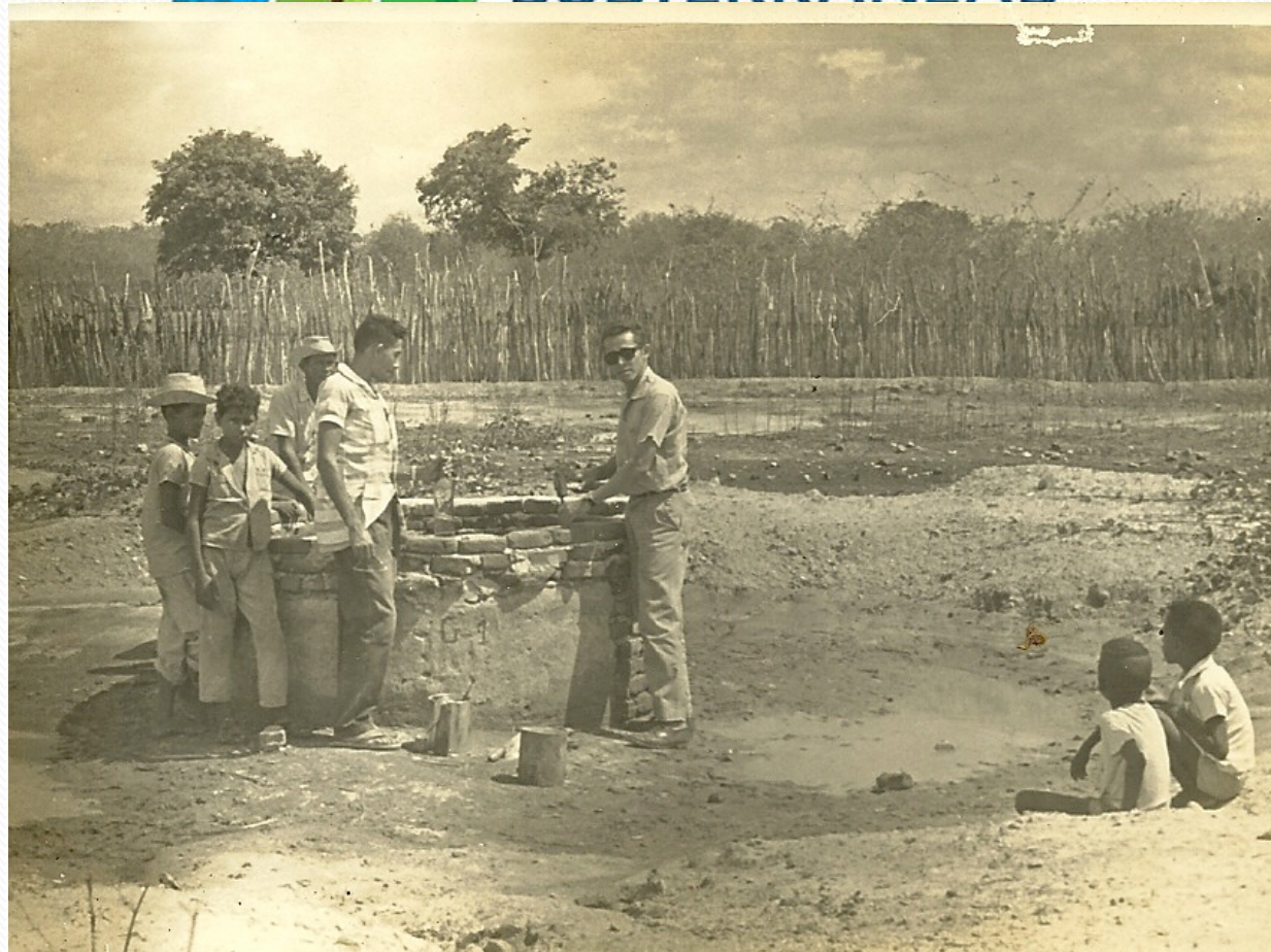
Foto 5 – Fixando parafuso com cimento na margem de um poço amazonas da rede de monitoramento para marcar e nivelar o ponto de referência das medidas de NE nas aluviões do baixo Jaguaribe (Município de Russas – CE 1963).
