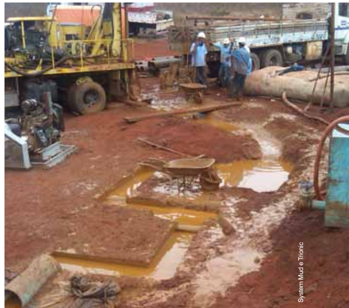
Preparação de fluido de perfuração
