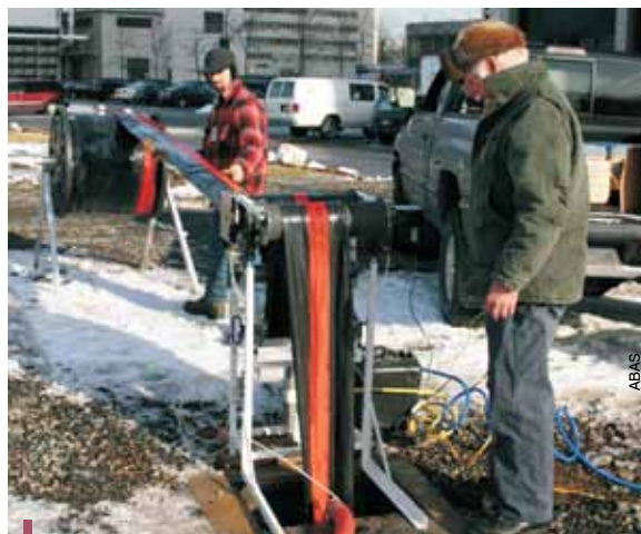
Perfilagem da condutividade hidráulica durante a instalação é uma das vantagens do “liner”
