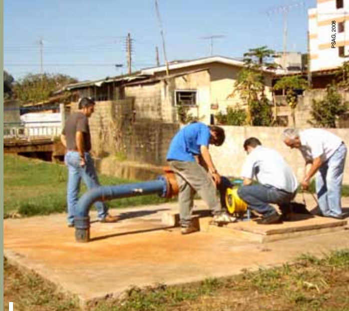
Medição dos níveis de água nos poços da rede do SAG em Ribeirão Preto (SP)
