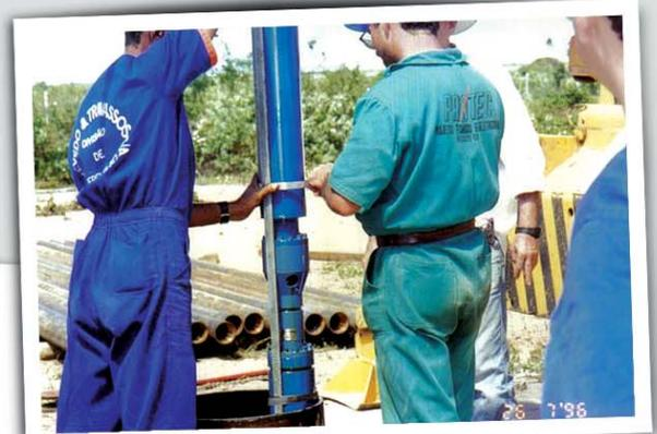
Instalação de conjunto de bombeamento tipo Centerlift a 500 metros de profundidade, Hidrogesp. Bodocó (PE), 1995
