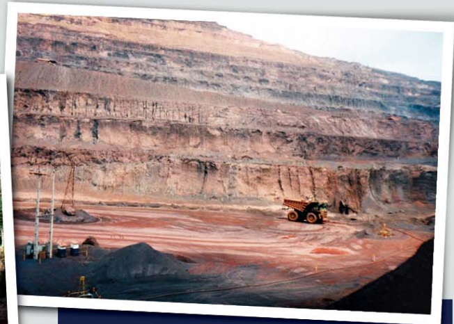
Poços para rebaixamento do nível d'água: Mina do Cauê – Vale – Minas Gerais, 1996
