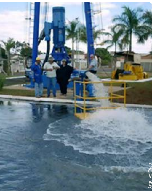
Instalação de moto bomba vertical a 420m de profundidade, para captação de 250 m 3 /hora de água do Aquífero Guarani, em Uberaba (MG).
