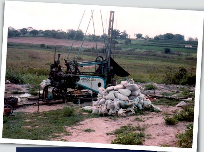
Sonda Percussora Sueca Marca Craelius da HIDROGESP – 1980
