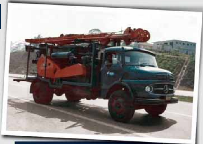
Sonda percussora para manutenção de poços – Air Lift. São Paulo – 1980
