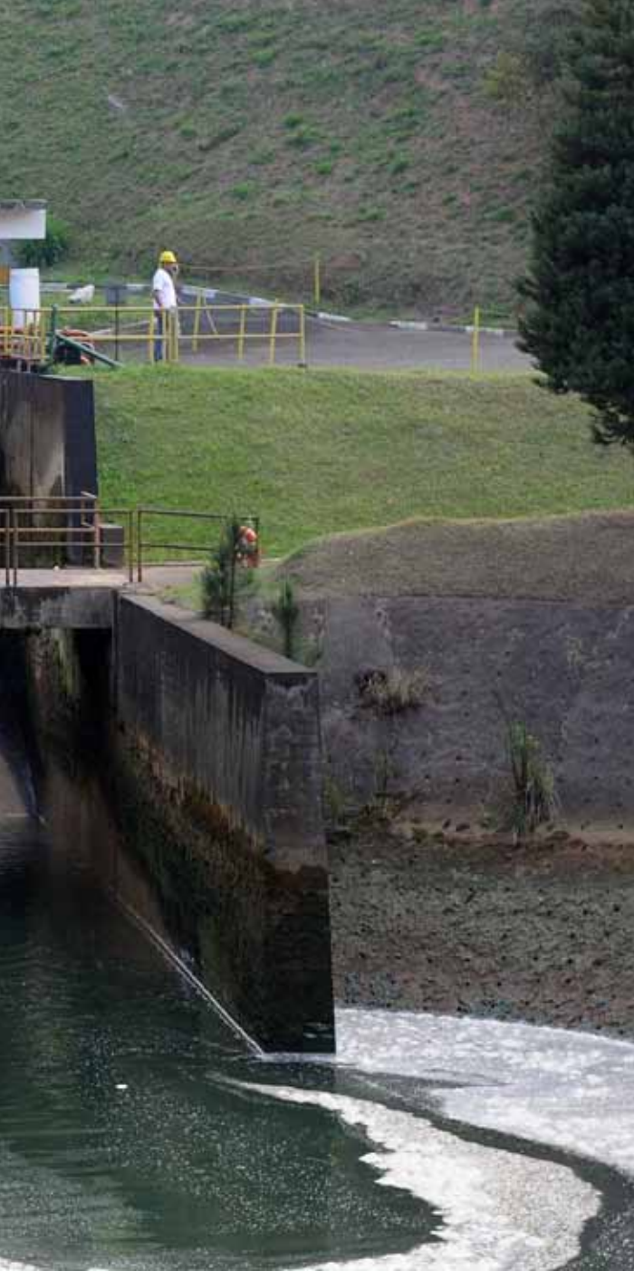
Manutenção do sistema Cantareira
