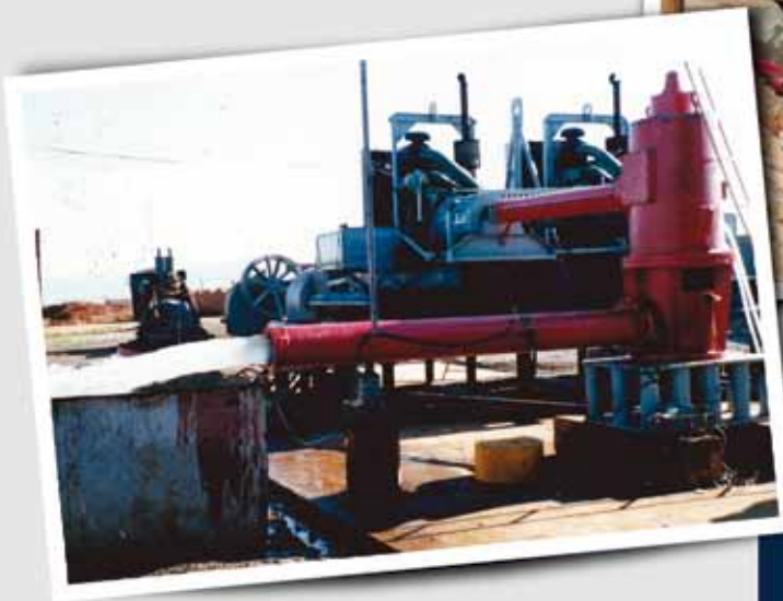
Bomba de Eixo Prolongado Pluvius, com 600 HP para teste de bombeamento - CONTEP. Araraquara (SP) - 1993
