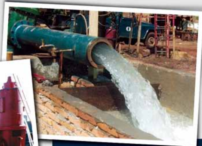
Teste de Bombeamento em Poço CPRM São José do Rio Preto (SP) - 1978
