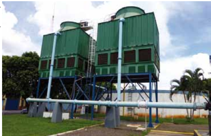
Poço em Birigui tem 1.350 m de profundidade e produção de 500 m 3 /h
