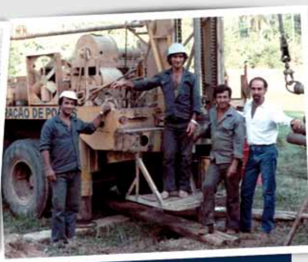
Último poço construído pela Cia. T. Janer - Ravena (Marcílio T. Nicolau à direita). Sabará (MG), 04/07/1984
