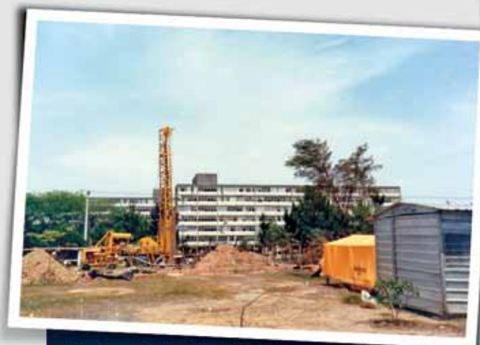
Perfuração de Poço Tubular Profundo. Raia Olímpica, Cidade Universitária/USP, São Paulo (SP). Hidrogesp - 1990
