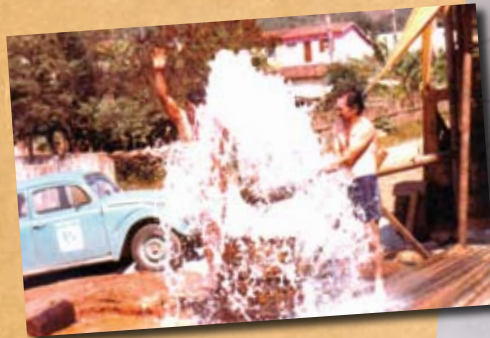
POÇO EM CAJAMAR-SP (1981) Proprietário: Sabesp Aquífero cárstico com caverna de 9 metros de profundidade. Vazão de produção 150 m 3 /h.
