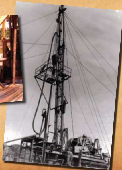
SONDA ROTATIVA CARDWELL Importada pela empresa Air Lift no início dos anos 70 para perfurar os primeiros poços no Aquífero Guarani em grandes profundidades.
